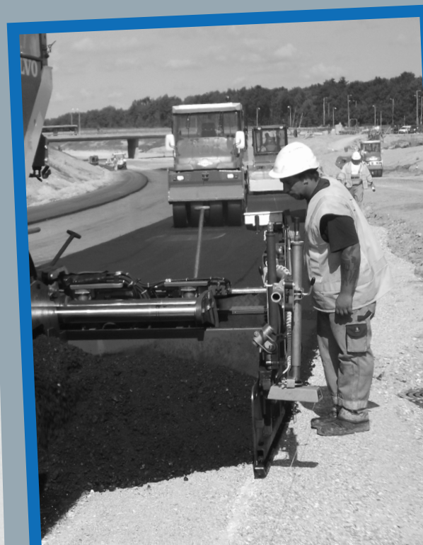
Комплект Mini-Line® HS301 для контр. выс. отметки с ультразвуковым датчиком G224 при вып. работы от струны
